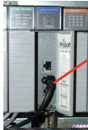
Der DF1-Anschluss erfolgt an der mittleren RJ45-Buchse.
