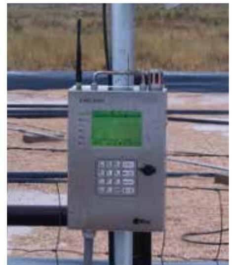
Il controller FMC-2000 può monitorare fino a 24 rivelatori wireless MeshGuard e contiene cinque relè programmabili che possono attivare allarmi esterni o controlli di processo.
