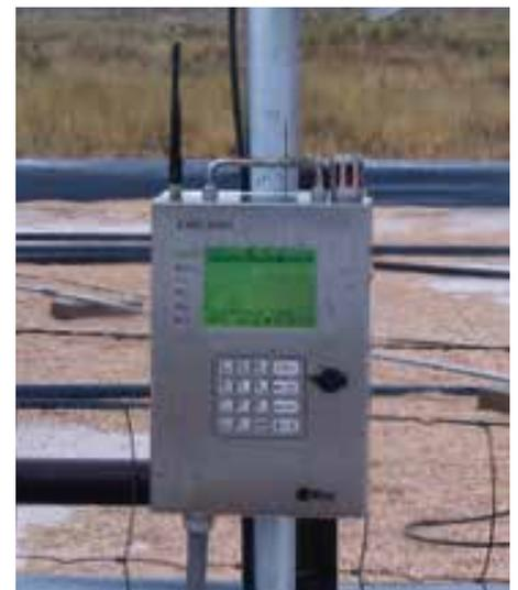
Der FMC 2000 Controller kann bis zu 24 drahtlose MeshGuard Detektoren überwachen und enthält fünf programmierbare Relais, mit denen externe Alarmer oder andere Prozess-Schritte angesteuert werden können.
